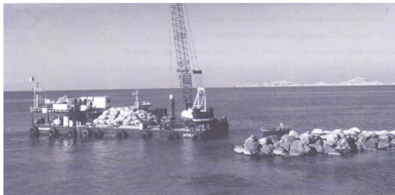
Photo illustrant le ponton grue et son amarrage sur site d'intervention
