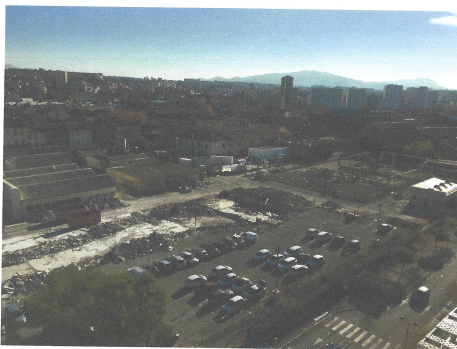
Partie sud du site avec le poste GRT-Gaz
