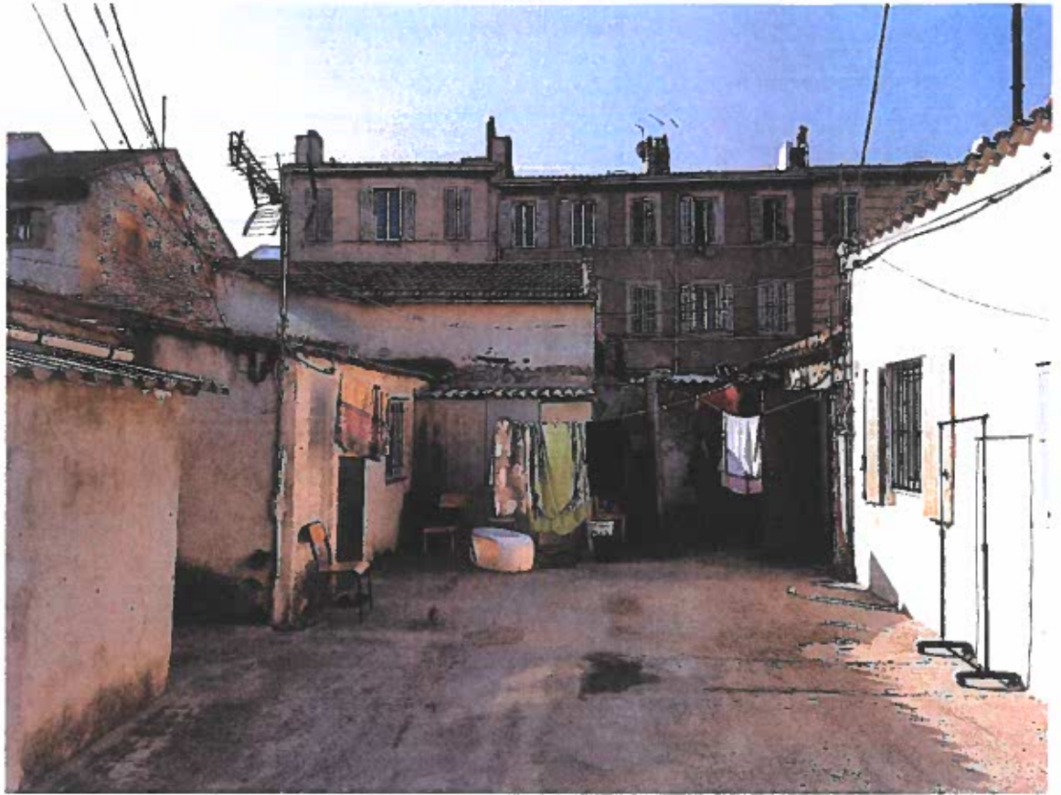
■ Cour commune de l'immeuble sis 23, traverse Antoine Donaz 13015 MARSEILLE
