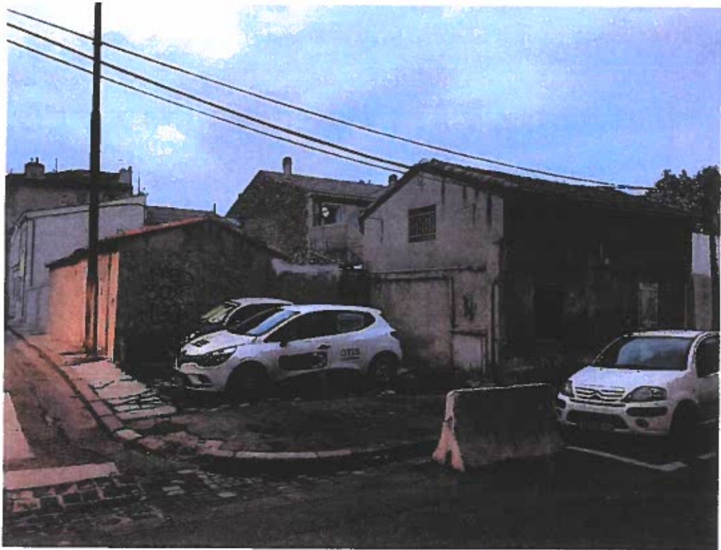
■ Façade de l'immeuble sis 23, traverse Antoine Donaz 13015 MARSEILLE (vue angle traverse Antoine Donaz à droite et traverse Antoine Caria à gauche)
