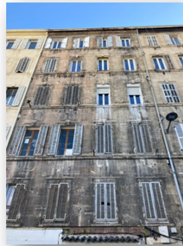
Immeuble façade 8 rue Eugène Pottier
