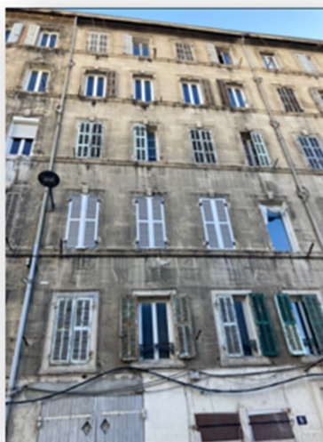
Immeuble façade 6 rue Eugène Pottier
