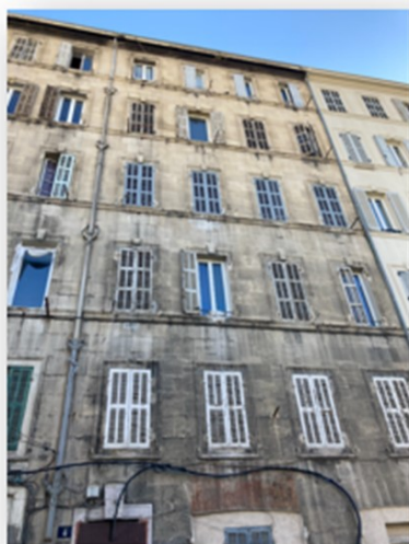
Immeuble façade 4 rue Eugène Pottier
