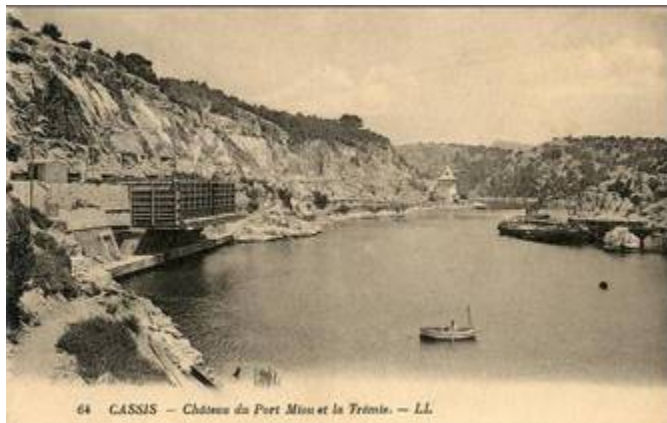
La « nouvelle » trémie
