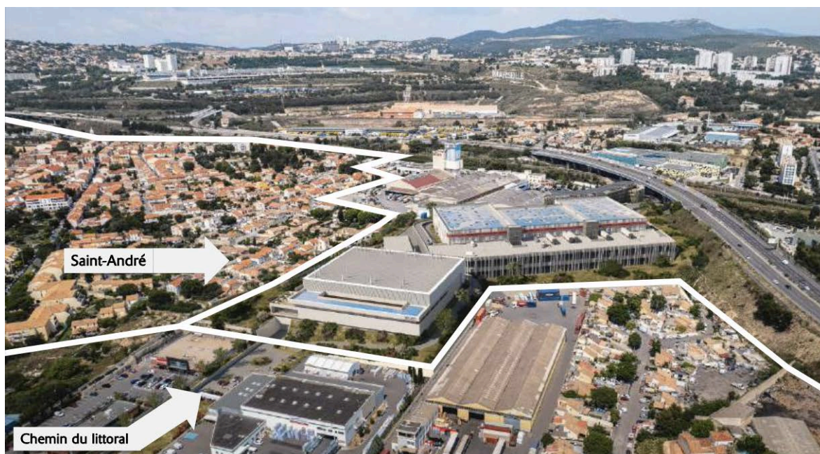
Vue d'ensemble du projet dans son environnement immédiat
