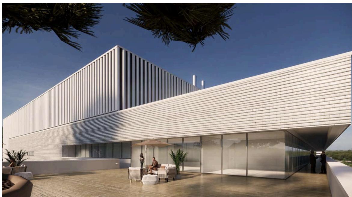
Façades du data center
