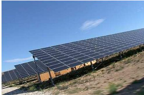
Cette centrale est constituée d'exactly 145 454 panneaux photovoltaïques à couches minces, une technologie de dernière génération. L'ensemble des panneaux, orientés vers le Sud et inclinés de 25 degrés, constitue un parc d'une surface totale de 10,8 hectares.
