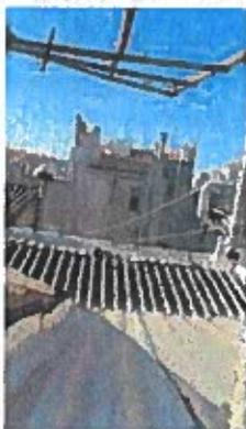
**\*La surélévation des niveaux R+5 et R+6 présentent une structure hétérogène avec des descentes de charges ponctuelles en plein milieu des portées de plancher, générant des fissures**
