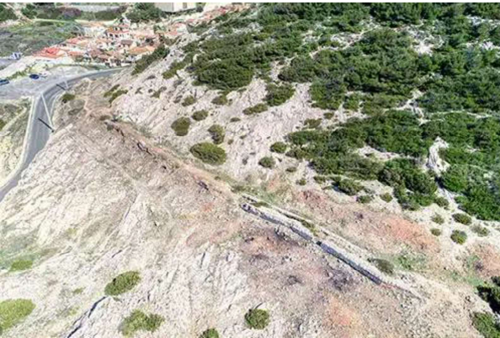
Etat initial avant travaux
