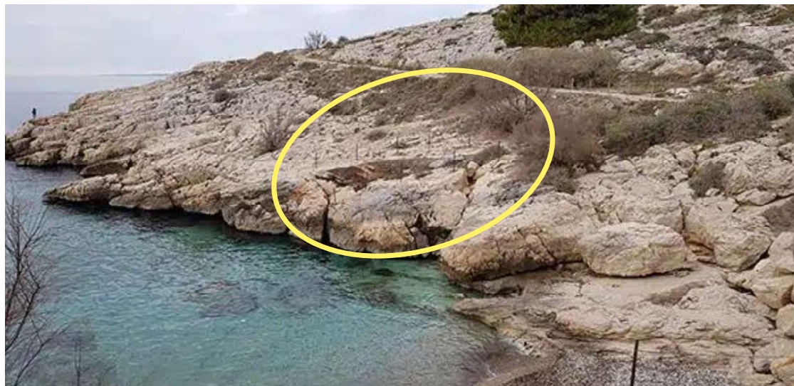
Etat initial avant travaux
