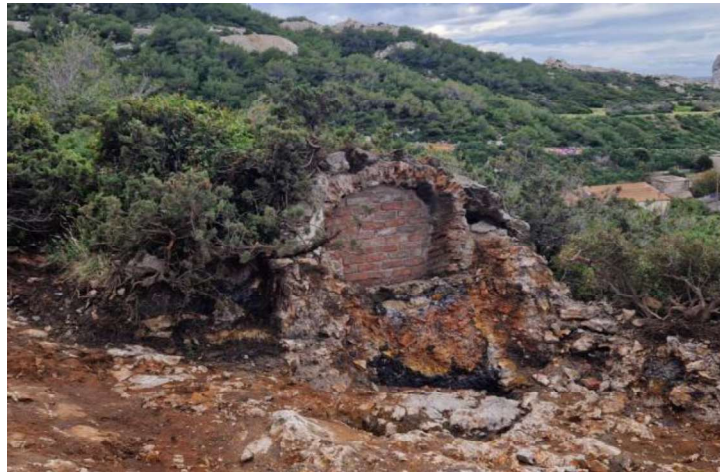
En cours de travaux
