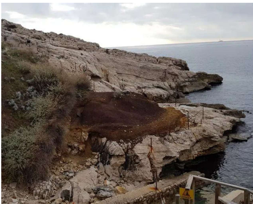
Etat initial avant travaux
