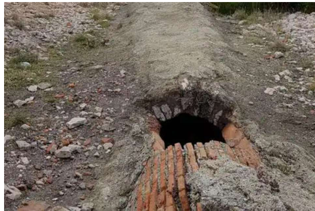
Etat initial avant travaux
