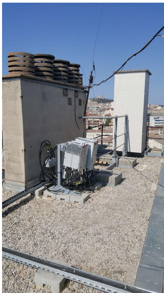
Photographies après travaux
