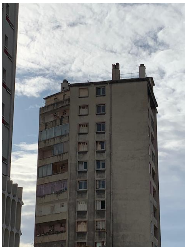
Photographies après travaux
