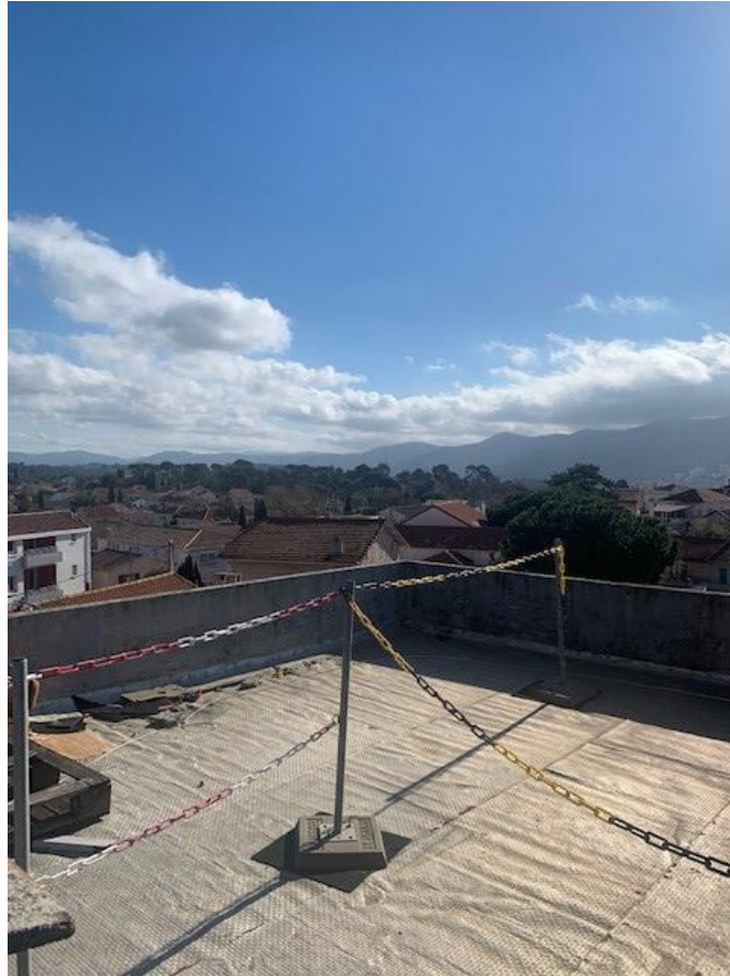
Photographies avant travaux S1
