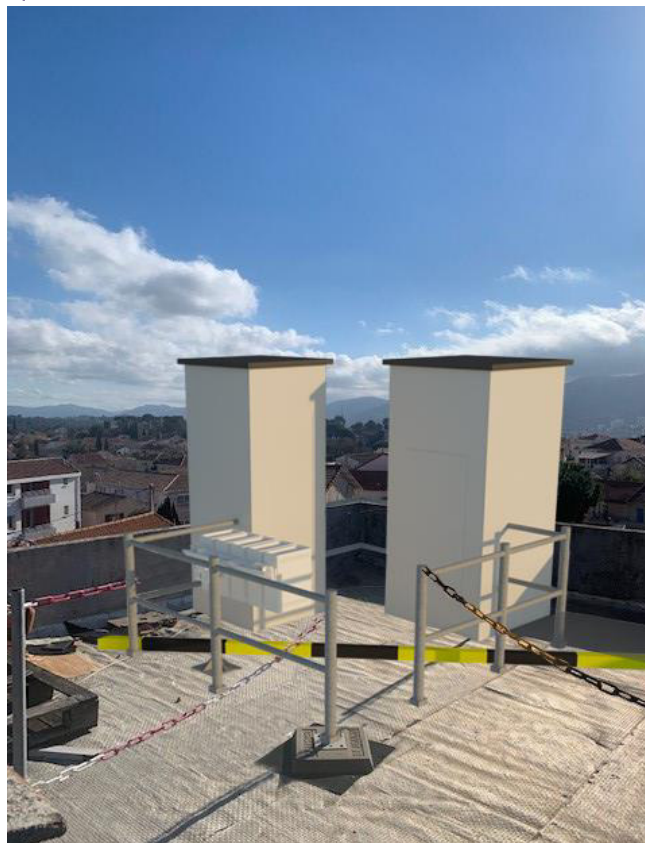
Photographies après travaux
