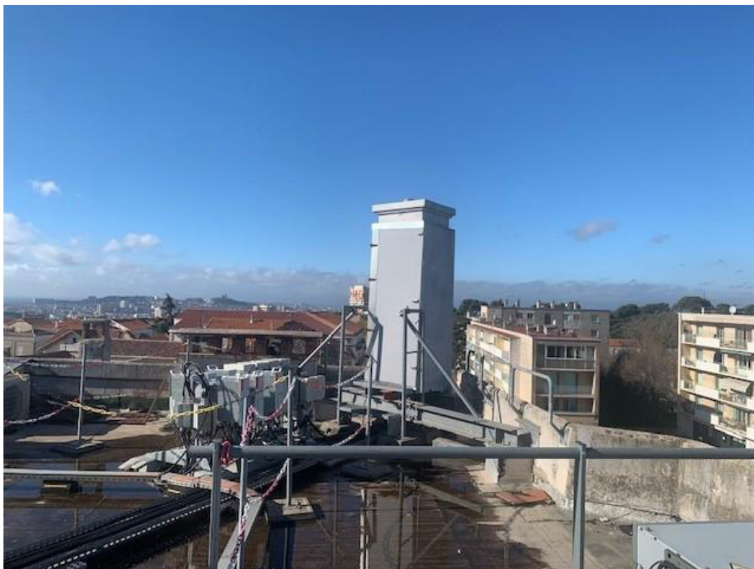
Photographies avant travaux So & S2
