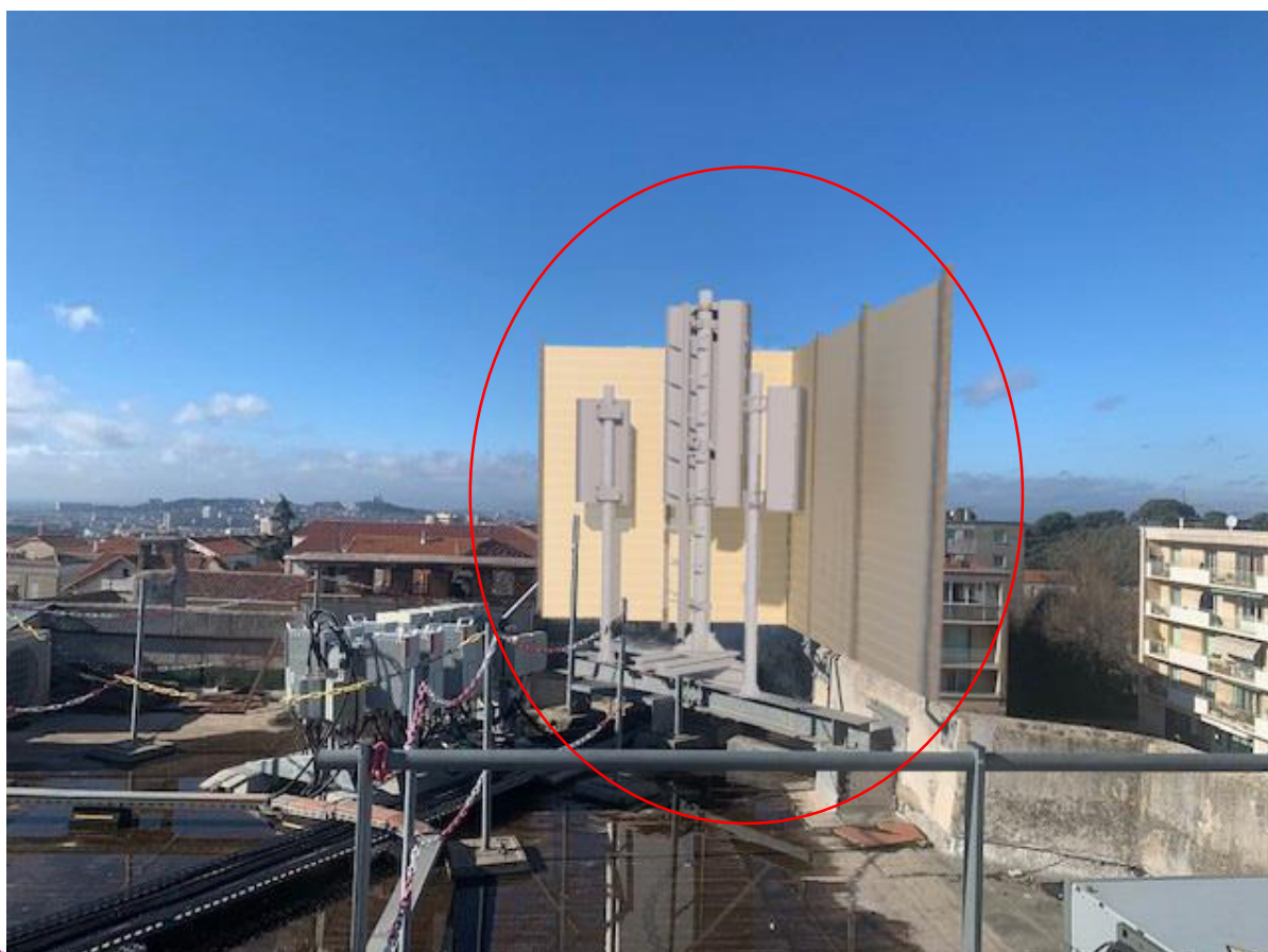
Photographies après travaux
