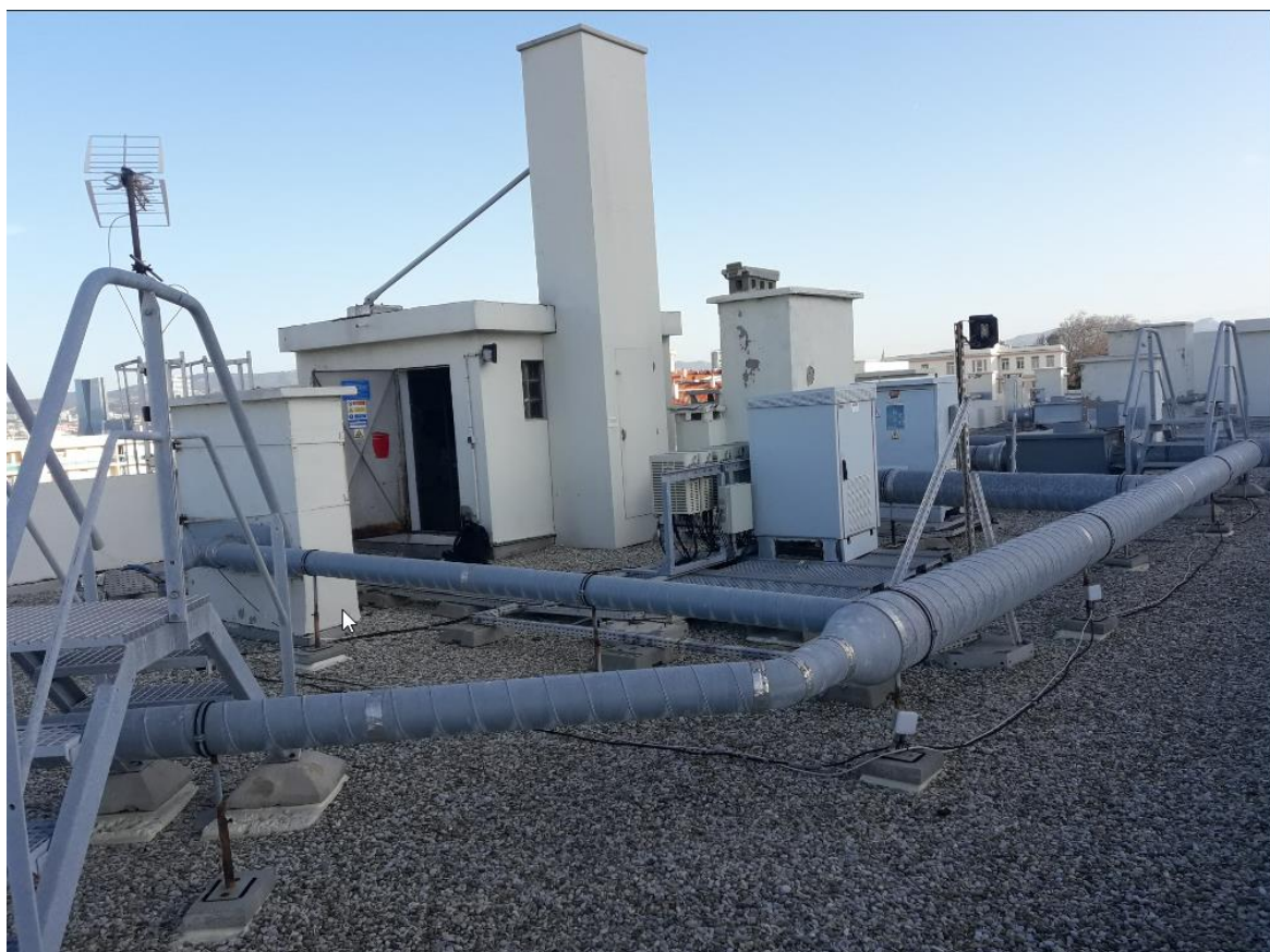
Photographies avant travaux
