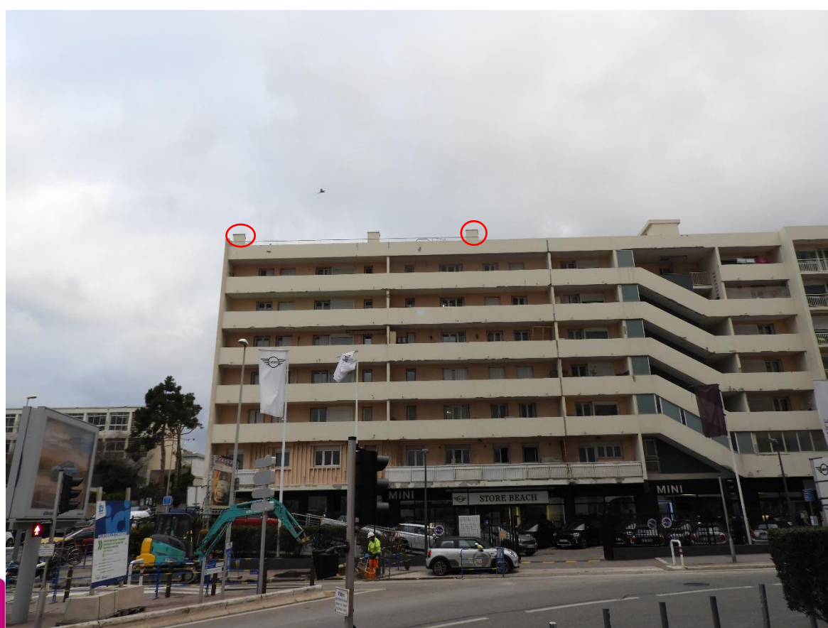
Photographies après travaux
