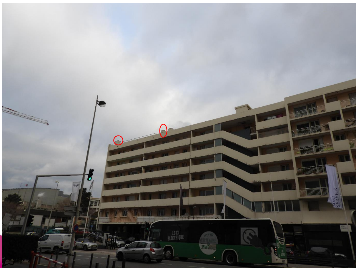
Photographies après travaux
