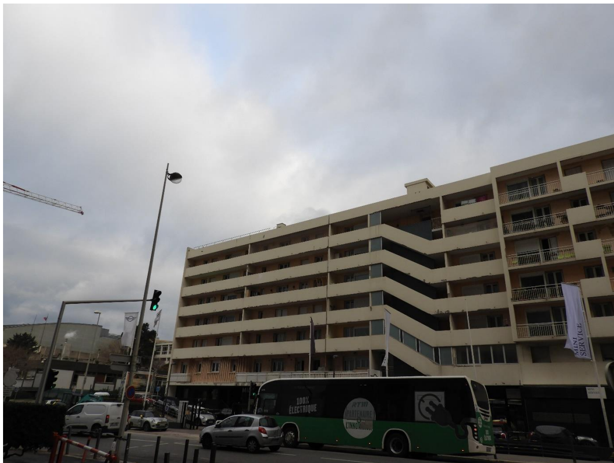
Photographies avant travaux
