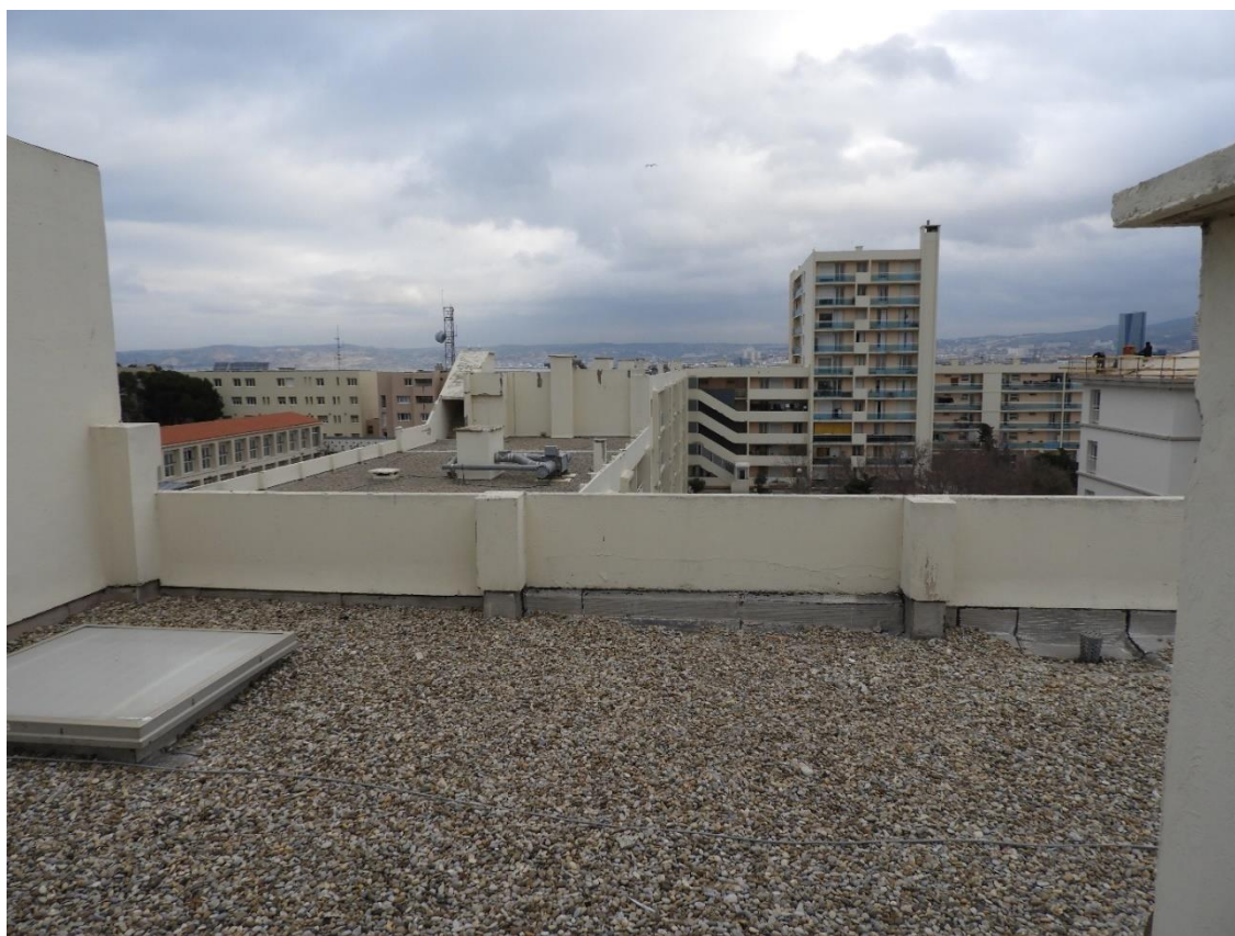
Photographies avant travaux
