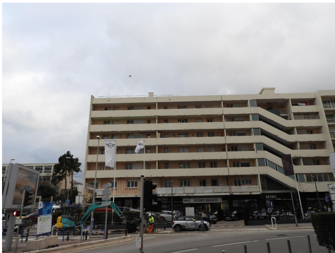
Photographies avant travaux
