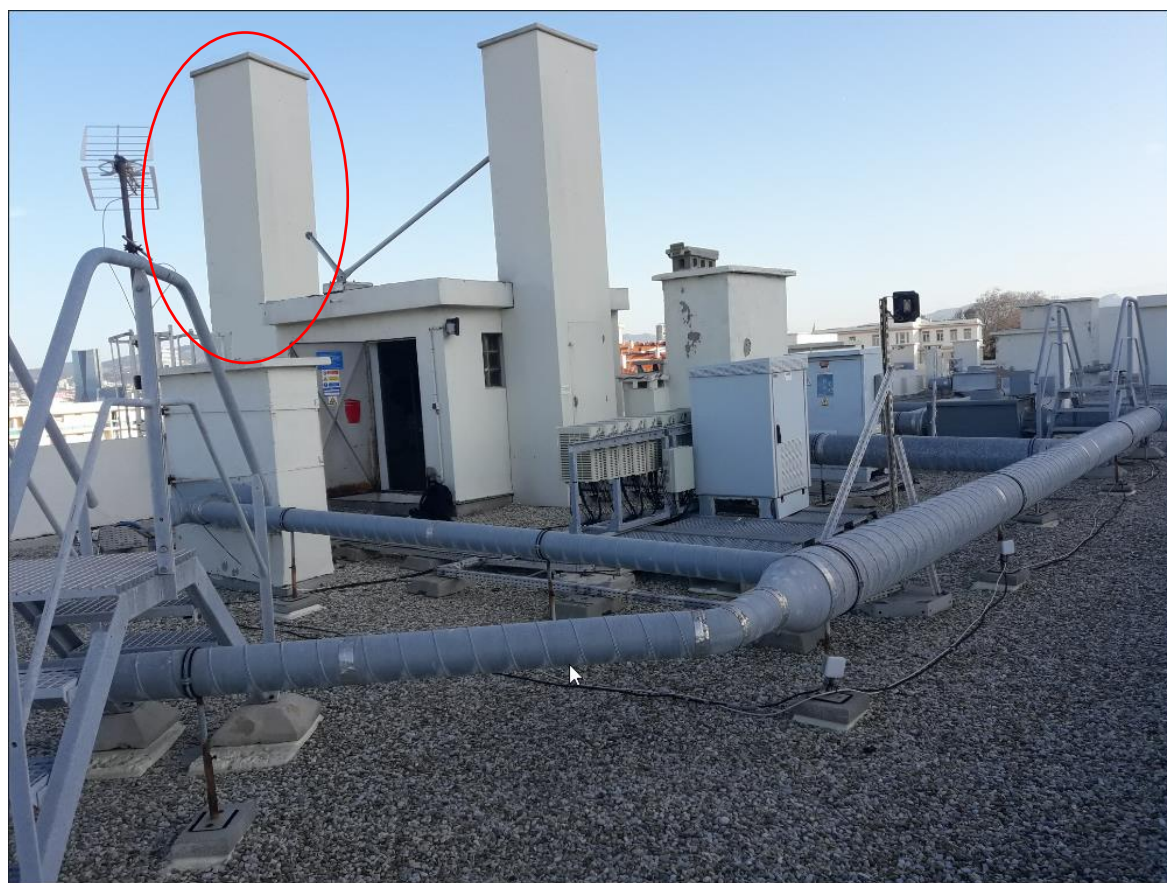
Photographies après travaux
