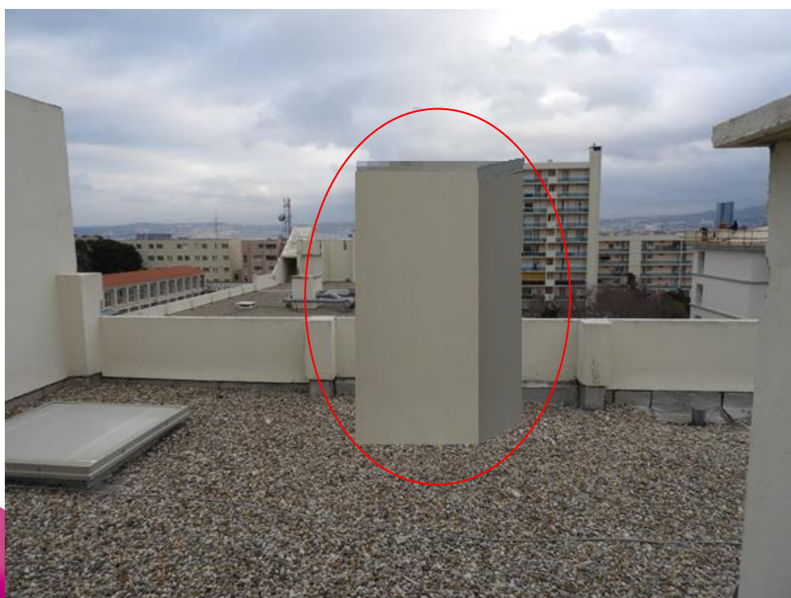
Photographies après travaux
