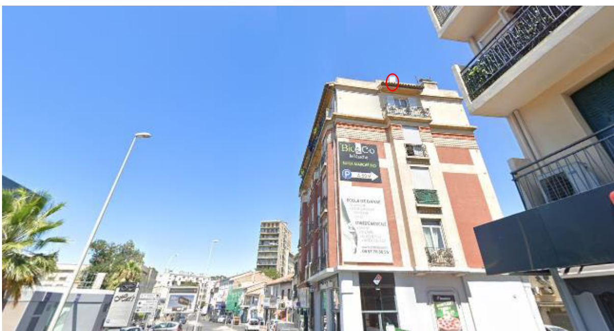
Photographies après travaux
