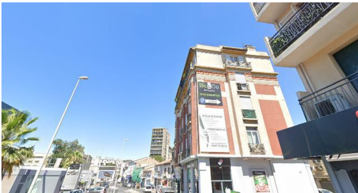
Photographies avant travaux
