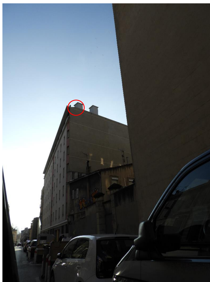
Photographies après travaux
