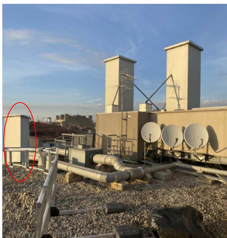
Photographies après travaux
