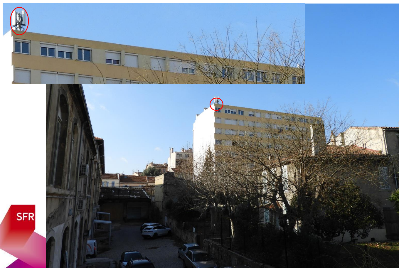
Photographies après travaux
