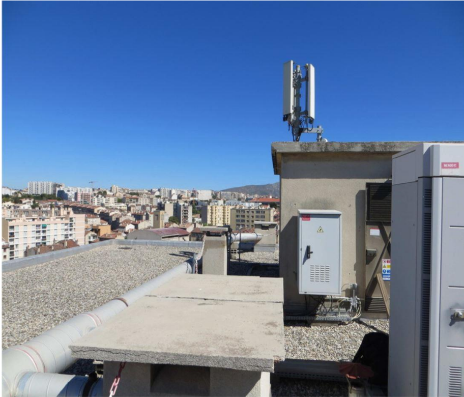
Photographies avant travaux S1
