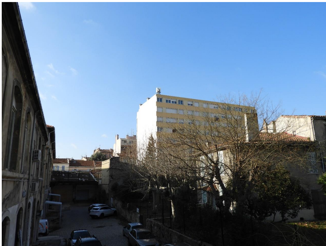
Photographies avant travaux
