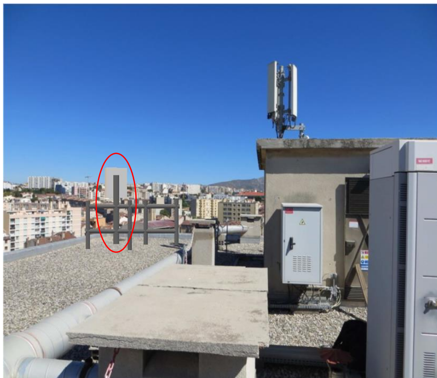
Photographies après travaux
