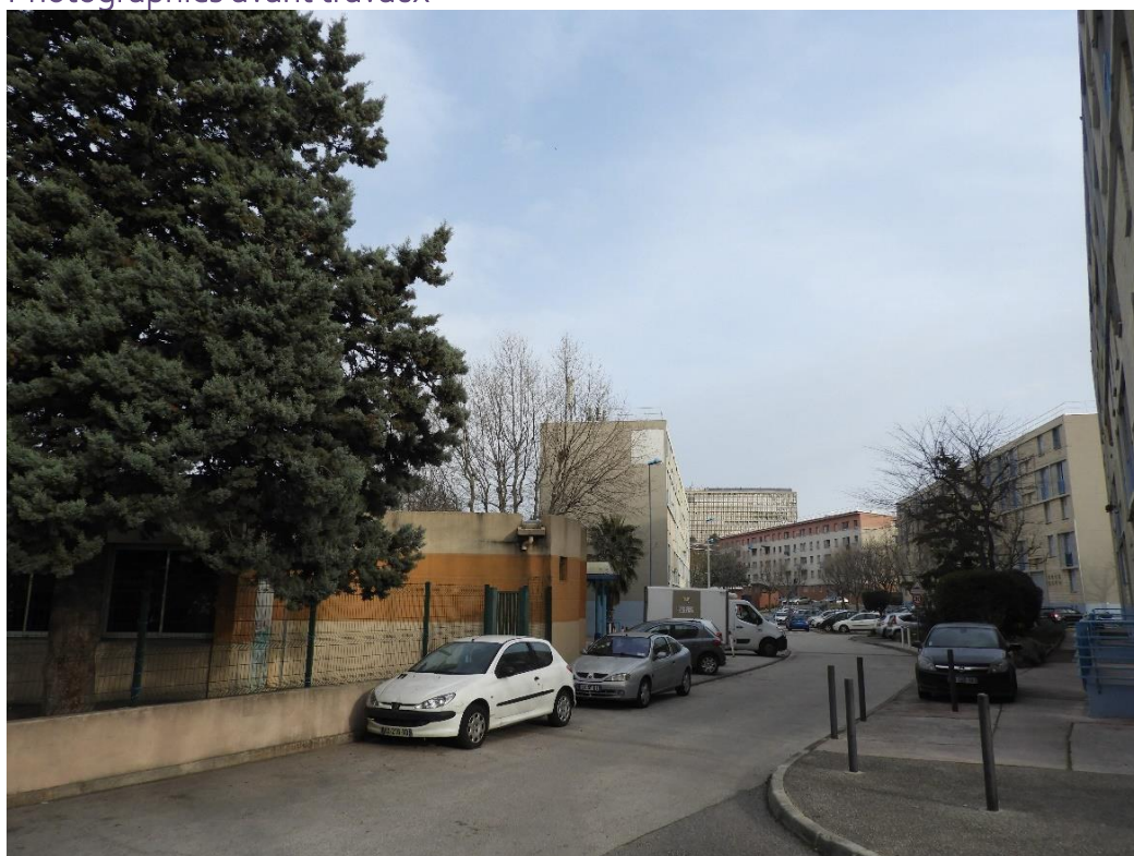
Photographies avant travaux
