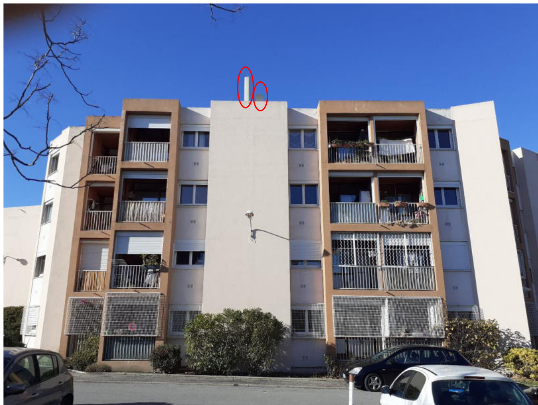
Photographies après travaux
