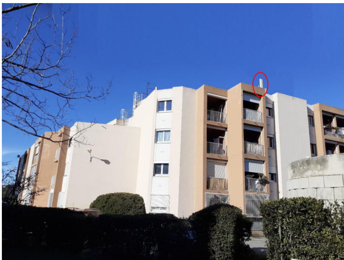
Photographies après travaux
