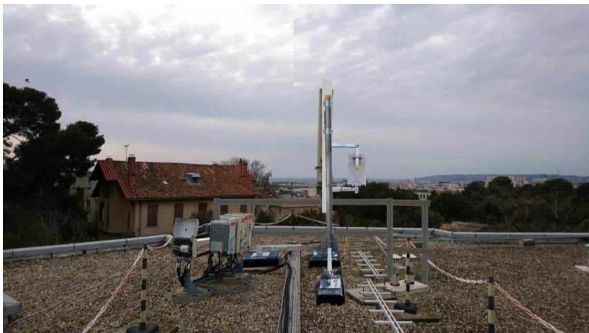
Photographies après travaux
