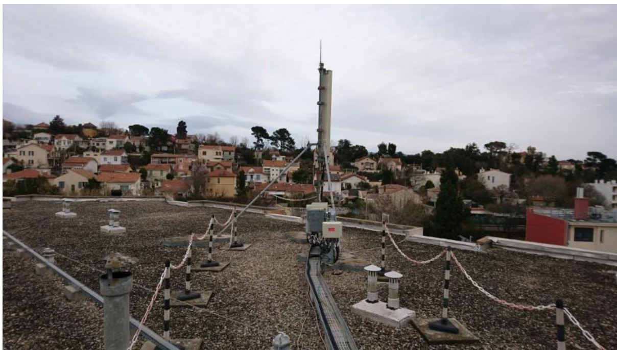
Photographies avant travaux
