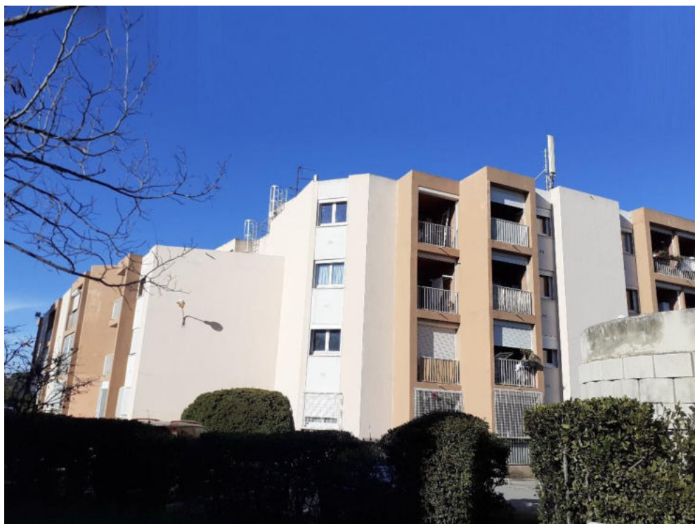
Photographies avant travaux
