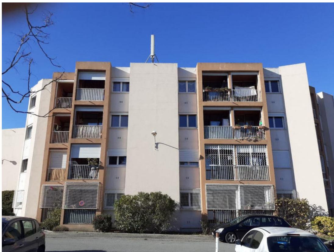
Photographies avant travaux
