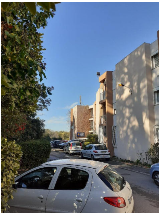
Photographies avant travaux
