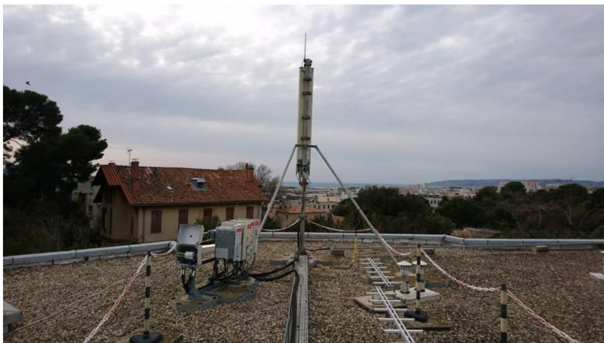
Photographies avant travaux
