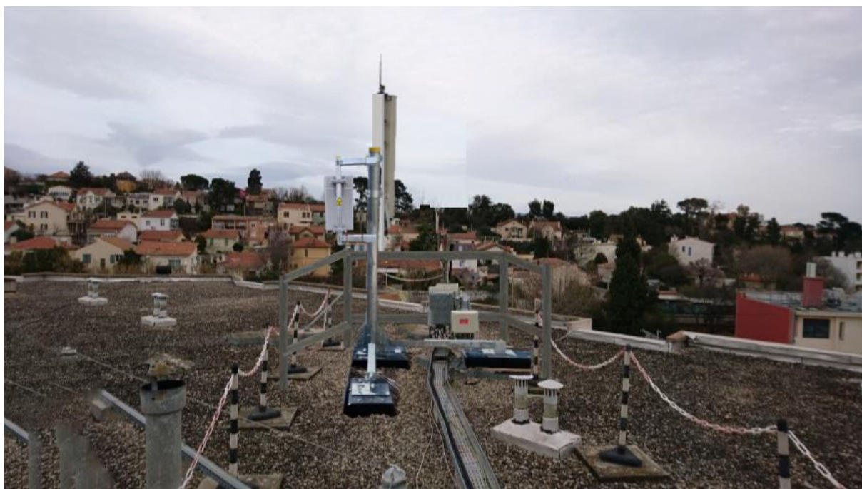
Photographies après travaux
