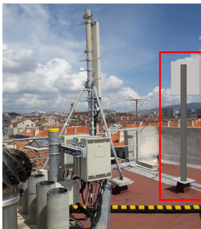
Photographies après travaux
