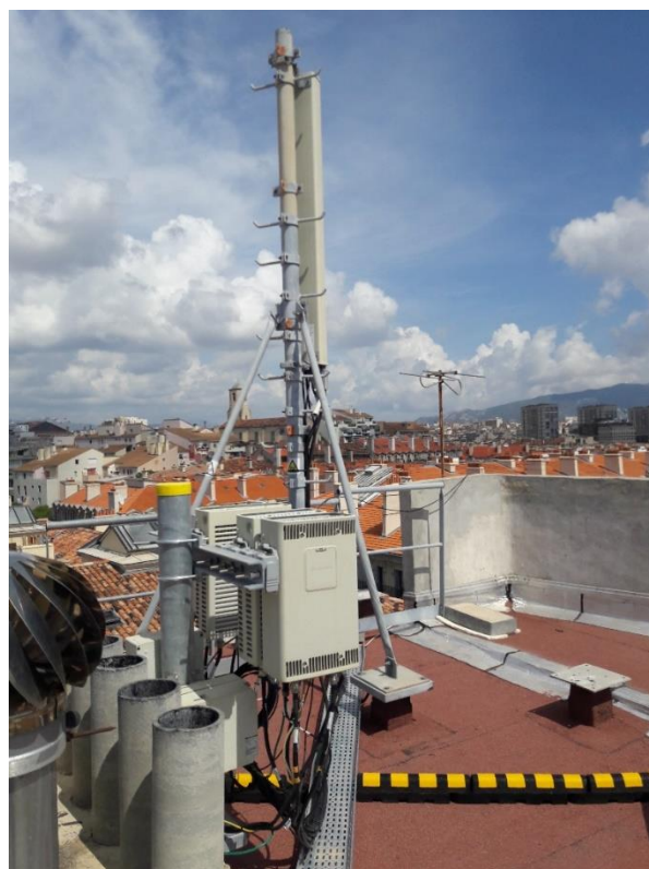
Photographies avant travaux S1
