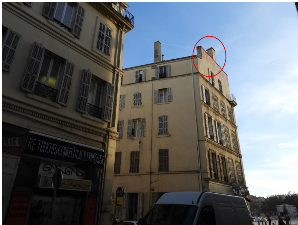
Photographies avant travaux
