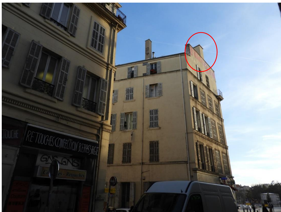
Photographies après travaux
