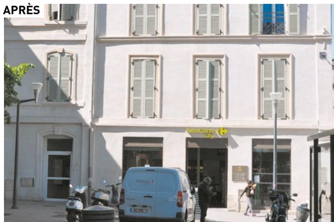
Une réalisation ayant permis de restituer la structure d'immeuble du rez-de-chaussée qui était masquée par des plaquages\* (notamment l'angle d'immeuble) : l'architecture d'origine est ainsi restituée.
