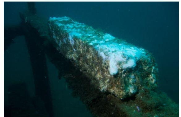
Figure 33 : Anode installée sur un récif ACI (printemps 2020)
