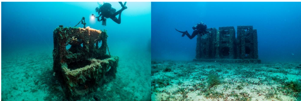
Figure 28 : Inspection visuelle qualitative de l'état des structures. A gauche : filières manquantes ou affaissées sur un amas de cubes, à droite : inspection d'un récif Fakir.
