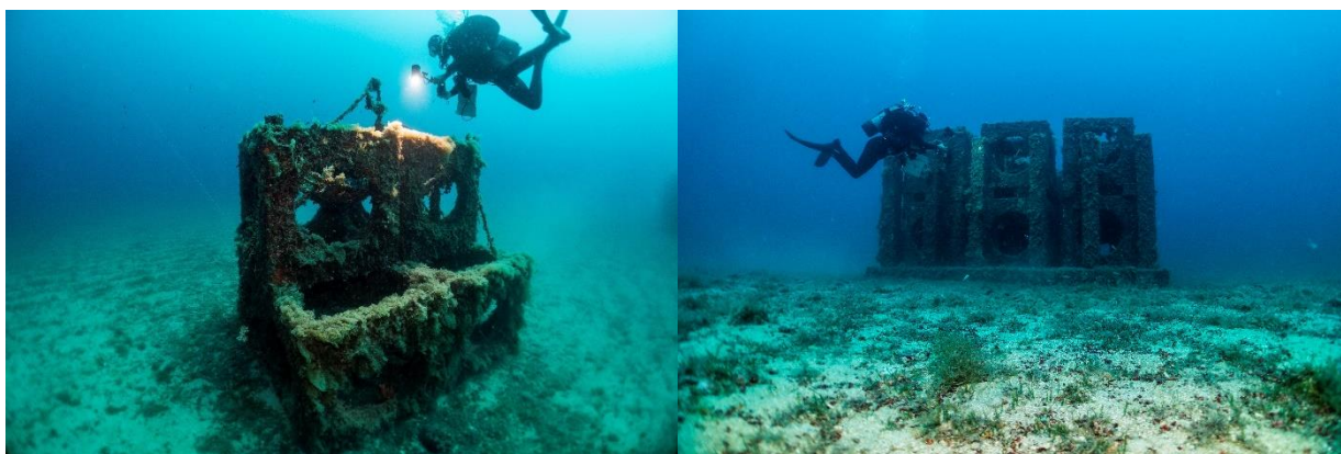
Figure 17 : Inspection visuelle qualitative de l'état des structures. A gauche : filières manquantes ou affaissées sur un amas de cubes, à droite : inspection d'un récif fakir.
