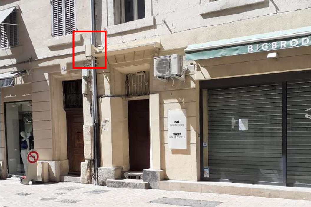
Photographie de près avant travaux
