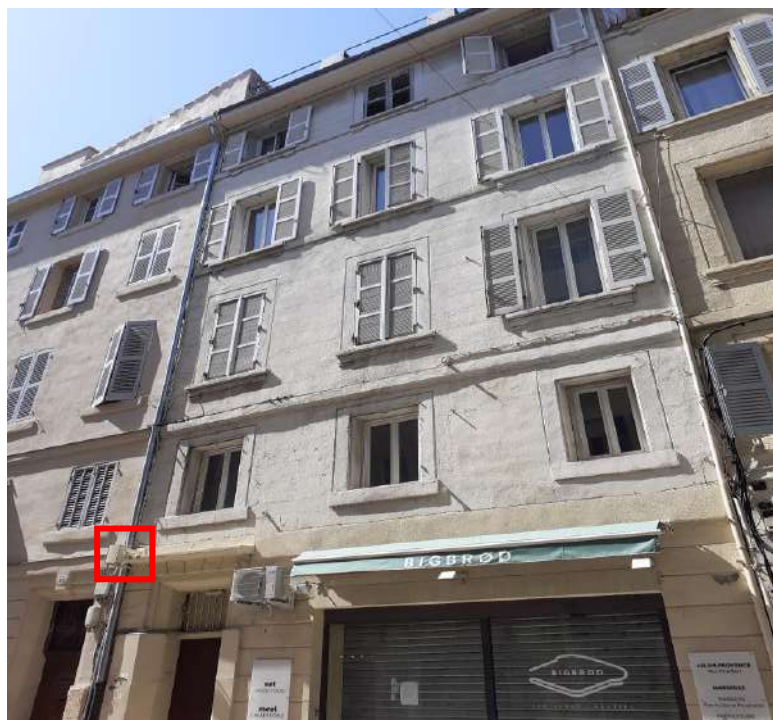
Photographie de loin avant travaux
