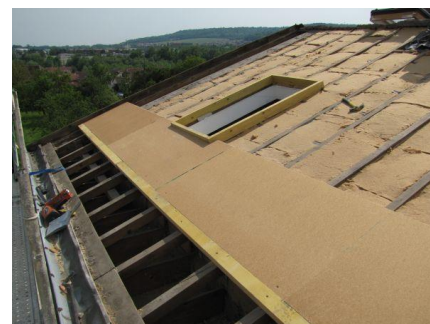
Exemple d'isolation sous (sarking) et sur toiture
